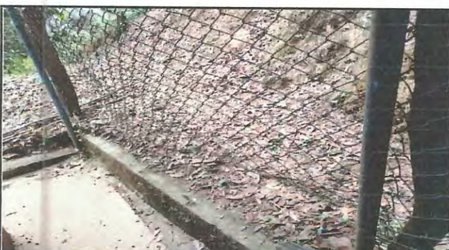
Foto 3: MEJORAMIENTO DE MURO PERIMENTRAL PARATE FRONTAL
