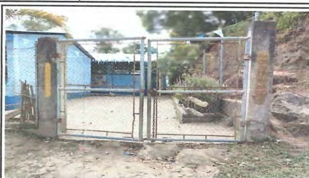
Foto 2: MEJORAMIENTO DE PORTON PRINCIPAL
