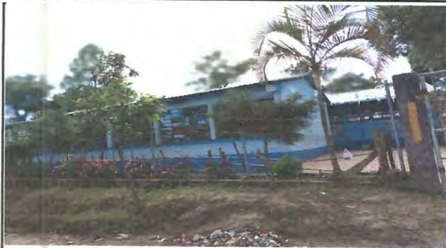
Foto 1: MEJORAMIENTO DE MURO PERIMENTRAL PARATE FRONTAL
